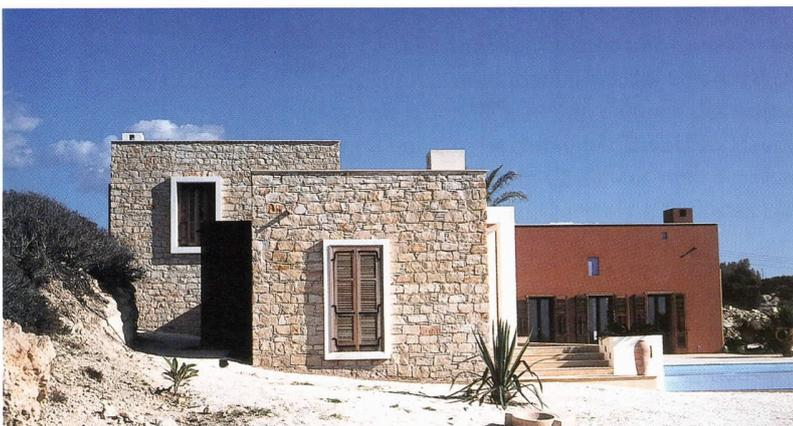
Die Fassade des Gästehauses bekam einen zweischaligen Aufbau, innen Ziegelmauerwerk außen Natursteinmauerwerk
